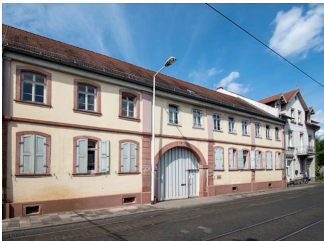
Straßenfassade der traufständigen Hofreite, 2022
