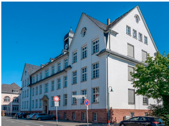
Straßenfassade der Gutenbergschule, 2022
