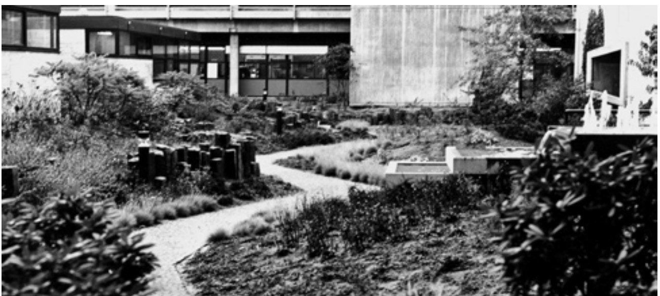
37.2 Historische Aufnahme, 1970er Jahre, landschaftliche Gestaltung des Innenhofs mit Wasserkaskade und Basaltstelen
