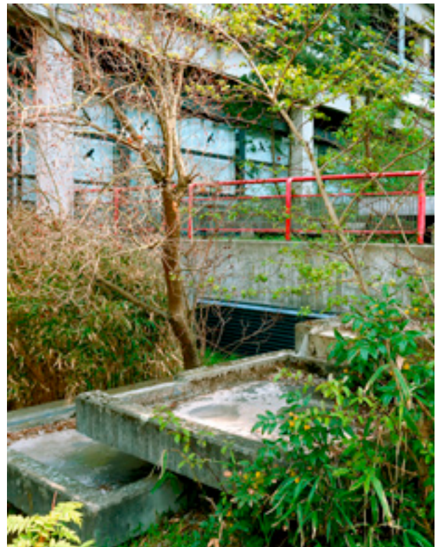
39.2 Wasserkaskade, nicht in Betrieb und eingewachsen. Foto 2019
