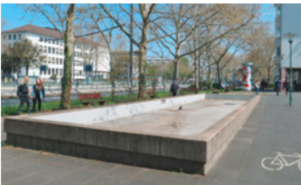
17.4 Wasserbecken, südliche Rheinstraße heute
