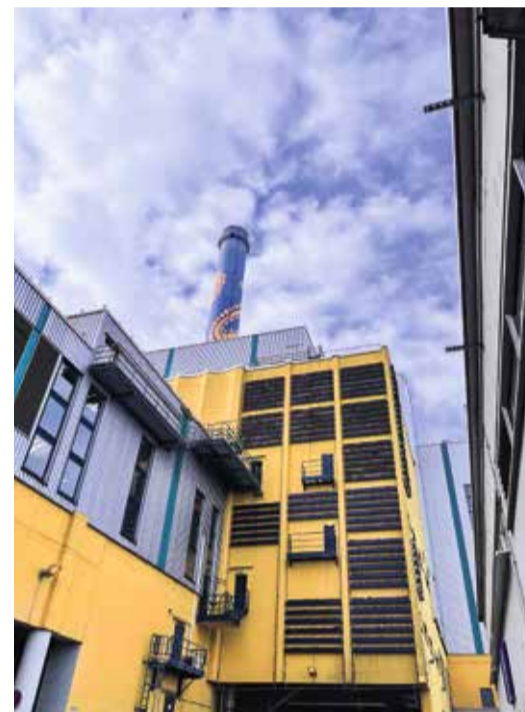
Wartungsarm und robust soll das System beispielgebend für andere Industriebauten werden.
