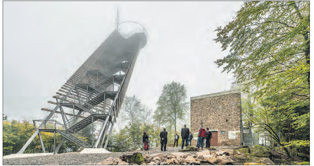
DIE FUNKANTENNE auf dem neuen Trommturm in Rimbach.
