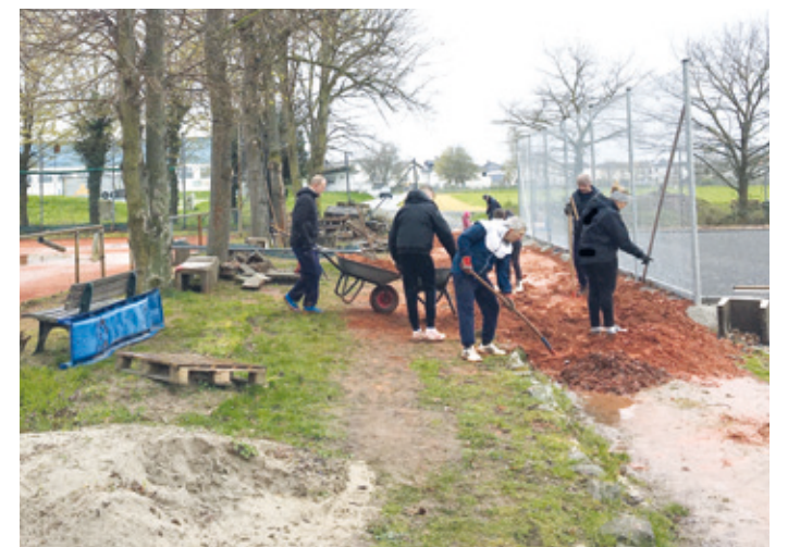
Beim Arbeitseinsatz am vergangenen Samstag packten ebenfalls viele Hände mit an – vor allem bei den Erdarbeiten rund um den neuen Allwetterplatz.
