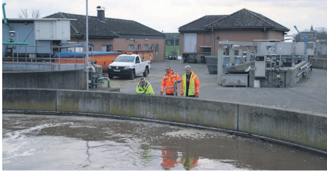
Bürgermeister Joachim Schledt, Kläranlagen-Leiter Ahmed El Makhtari und sein Stellvertreter Wolfgang Kleinheinz (v.l.) am Belebungsbecken, im Hintergrund ist das Betriebsgebäude zu sehen, an dem bald die Arbeiten beginnen. Foto: GM/Meike Mittmeyer-Riehl
