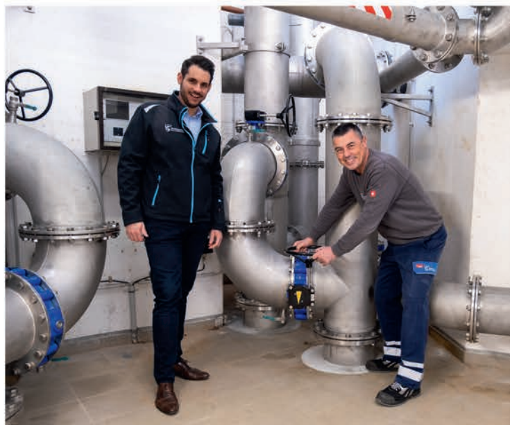
Christoph Pfaff und Vladan Arsic überwachen täglich die Sanierungsarbeiten.
