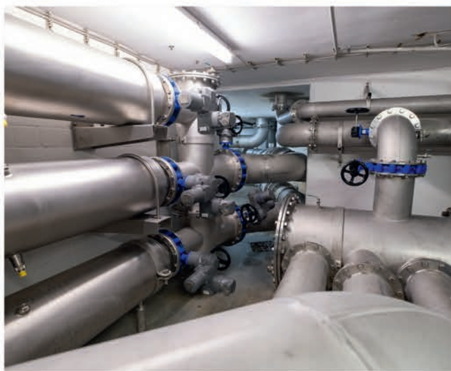
Neue Edelstahlrohre ersetzen die alten Stahlrohre.
