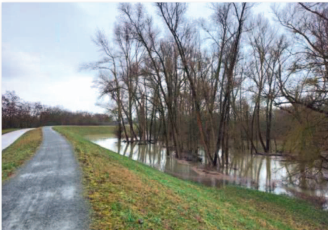
02.02.2021 Hochwasser am Damm hinter der IGS Mainspitze
