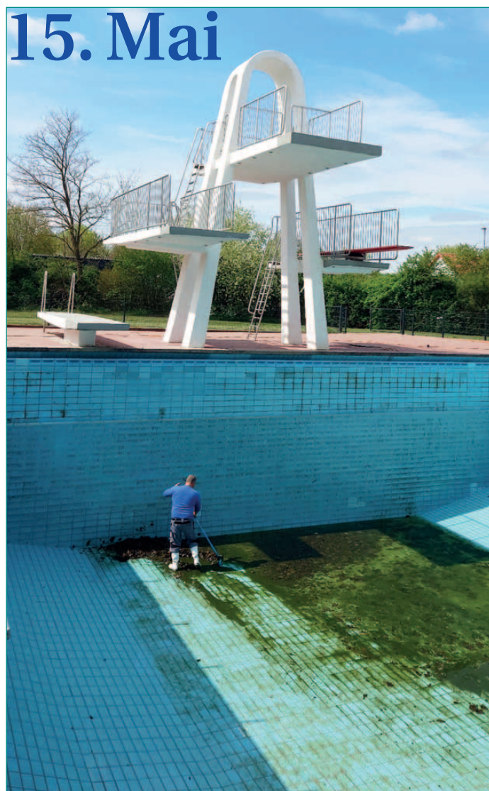
Eine gründliche Beckenreinigung und Ausbesserungsarbeiten nach vom Winter verursachten Schäden gehen dem Schwimmvergnügen voran.
