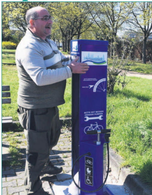
Mitarbeiter des Bauhofes installierten die neue Reparaturstation. Foto: Stadt Seligenstadt
