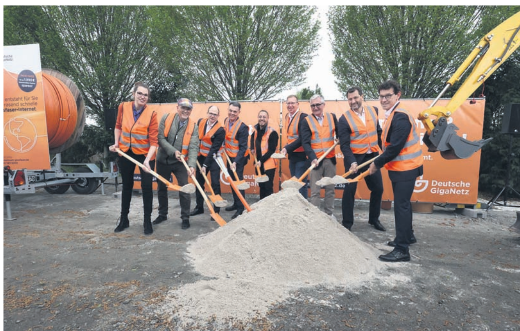
Mit einem symbolischen Spatenstich, an dem unter anderem Vertreter der Deutschen GigaNetz GmbH und der Stadt teilnahmen, fiel der Startschuss für den Ausbau des Glasfasernetzes in Rödermark. (Fotos: PS)
