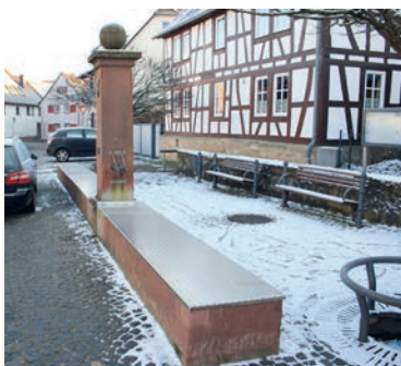
Neue Winterabdeckung für Weedtröge aus geriffeltem Aluminiumblech
