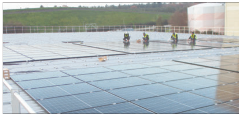
Die PV-Anlage in Darmstadt wird auf drei Produktions- und Logistikgebäuden installiert.
