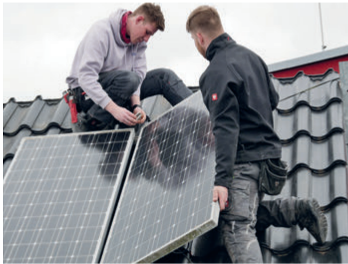
Für die Installation von Solar-Anlagen ist das Dachdeckerhandwerk, gemeinsam mit dem Elektrohandwerk der richtige Ansprechpartner. Foto: HF.Redaktion und ZVDH/akz-o
