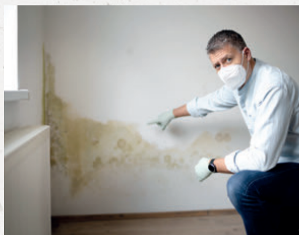
Die Außenecken und Außenwände sind besonders gefährdet für Schimmelbildung.
