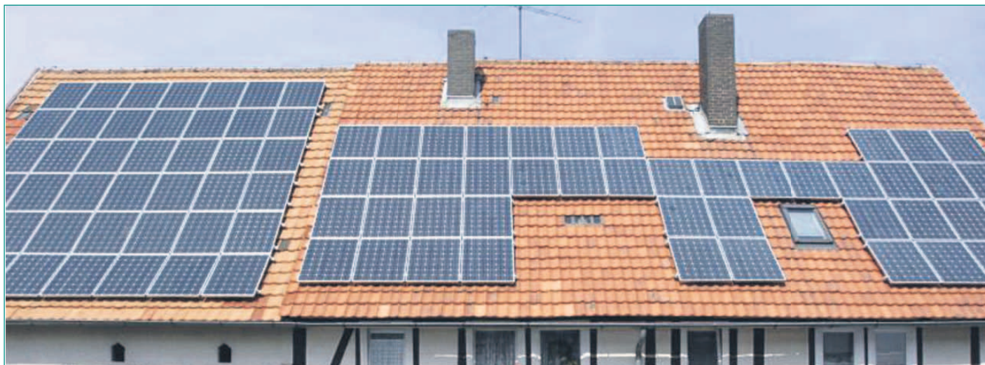
Solarelemente im Bereich der Seligenstädter Altstadt werden dem Denkmalschutz und Bauamt zufolge wohl nur im „geschlossenen Format“ (links) erlaubt sein. Wer das anders ausführt (rechts) wird zur Kasse gebeten und wieder abbauen müssen.
