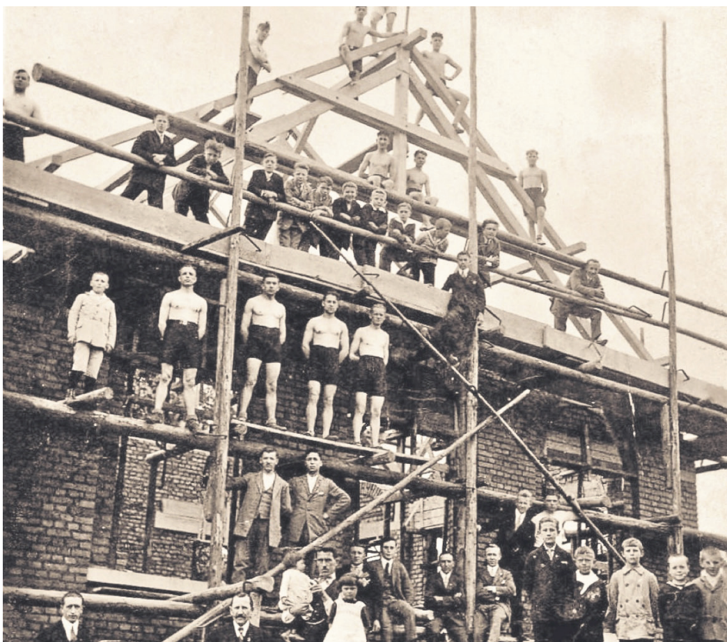
Die Turnhalle in Hausen wurde in Rekordzeit errichtet.
