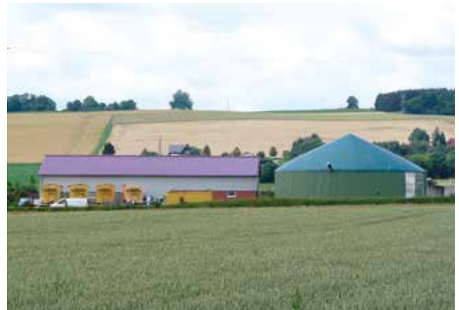
Landwirtschaftliche Biogasanlage mit Vor-Ort-Verstromung und Wärmenutzungskonzept
