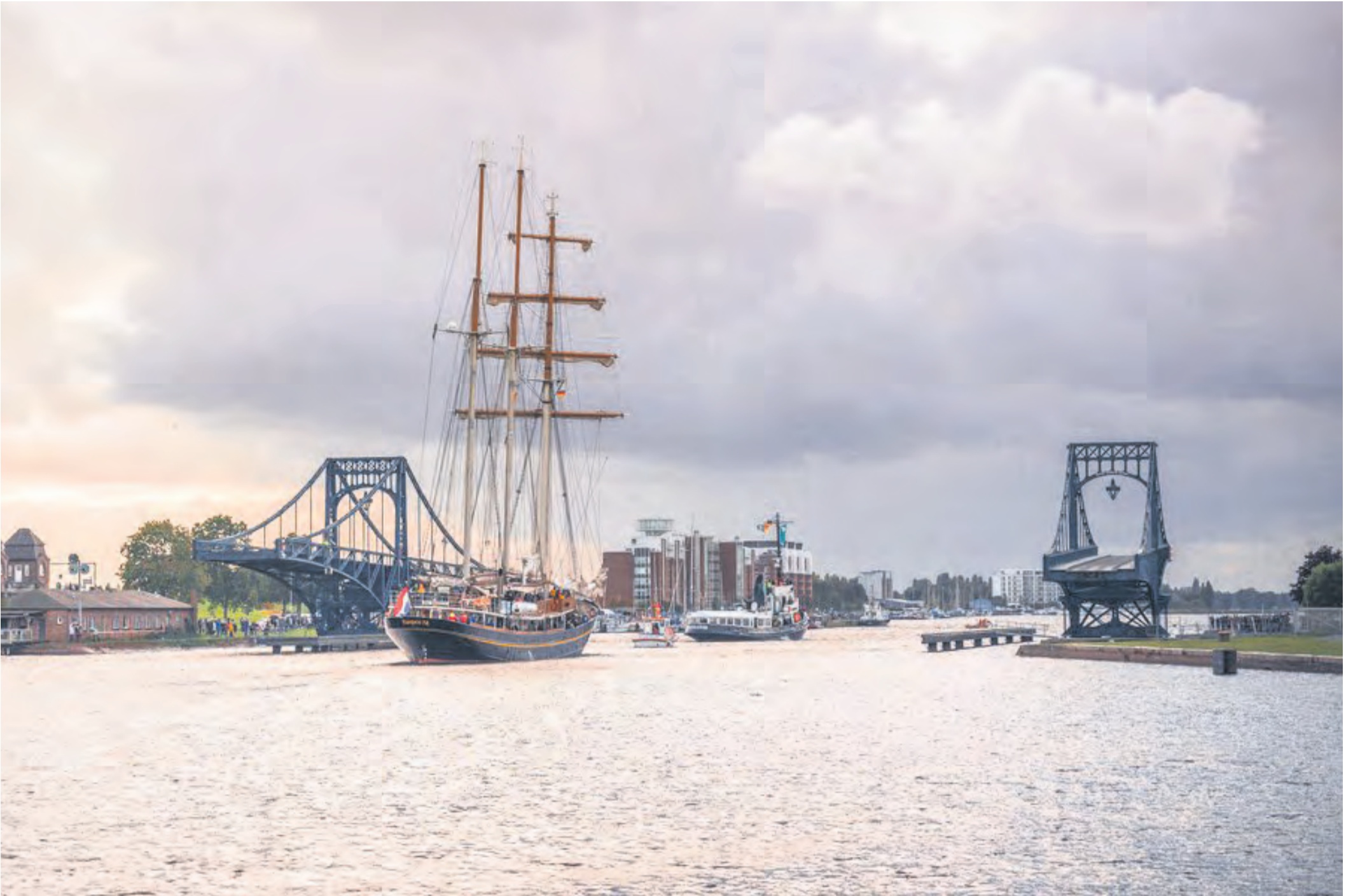
Traditionssegler laufen durch die geöffnete Drehbrücke zum Wilhelmshaven Sailing-CUP im Großen Hafen ein.
