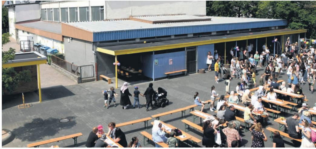
Eine der ältesten Sporthallen im Kreis: Die Eppertshäuser Mehrzweckhalle soll abgerissen und an selber Stelle neu gebaut werden, was aber noch mindestens fünf Jahre dauern dürfte. (Foto: jedö)
