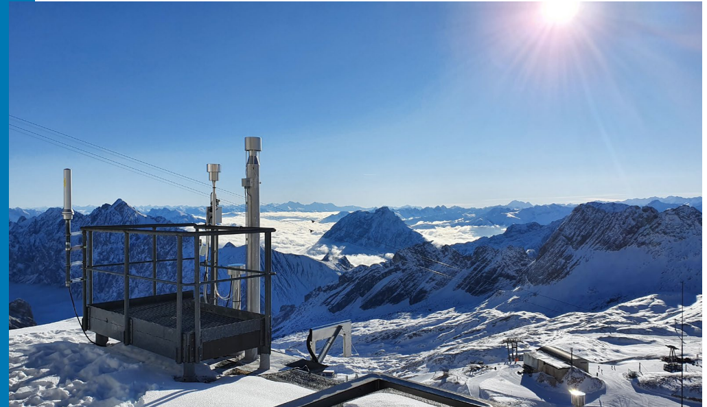
▲ Foto 2.10-2: Messgeräte am Schneefernerhaus
