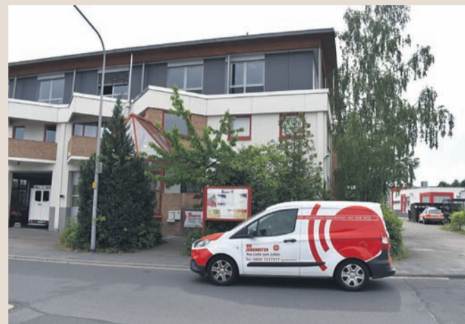
Die Johanniter-Unfallhilfe in Nieder-Roden: Das Gebäude ist mit Qualitäts-Fenstern mit Wärmeschutzglas ausgestattet. (Foto: p)
