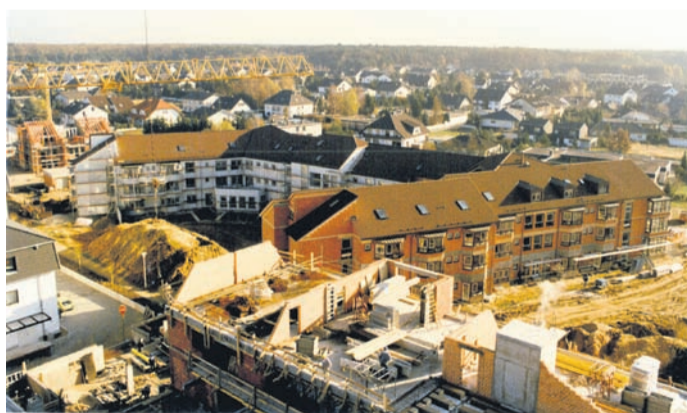
Eine Siedlung nimmt Konturen an... Blick auf den Pflegeheimkomplex (Haus Morija, Haus Mamre) und das Breidert-City-Center während der Bauphase. Foto: Initiative „Wir sind Breidert“
