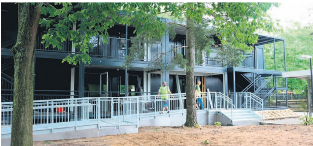
Die Außenansicht der Containeranlage. Im Vordergrund ist die Rampe zu sehen, die einen barrierefreien Zugang zum Gebäude ermöglicht. (Foto: Kreis Offenbach)
