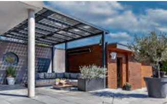
Foto: epr/Solarterrassen & Carportwerk GmbH
