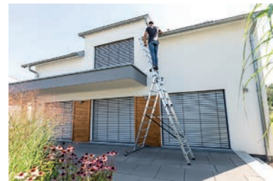
Dachrinnen reinigen: Mit einer Mehrzweckleiter geht das besonders sicher. Foto: dj-d-k/Munk Günzburger Steigtechnik
