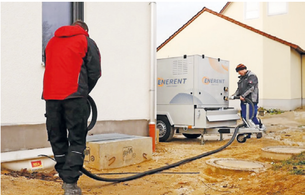
Eine gemietete Heizung wird auf einem fahrbaren Anhänger zur Baustelle gefahren. (Foto: djd/ENERENT)
