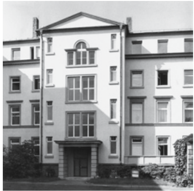
89.2 Anstelle Mollers Rotunde entsteht an der Ostseite ein neues Treppenhaus.
