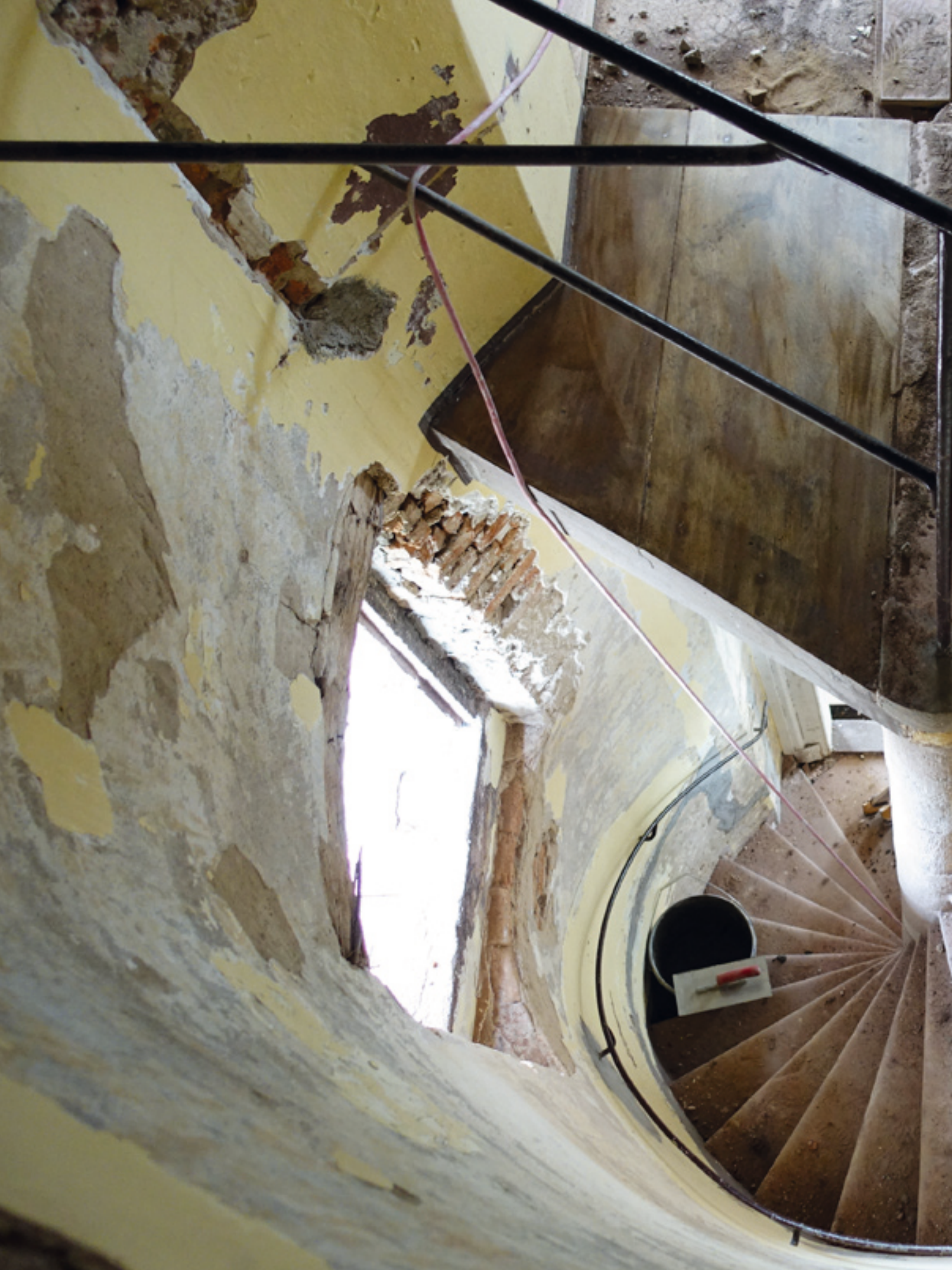
40.1 Treppenturm nach Abnahme der dunkelbraunen Farbschicht auf der Sandsteinwendeltreppe
