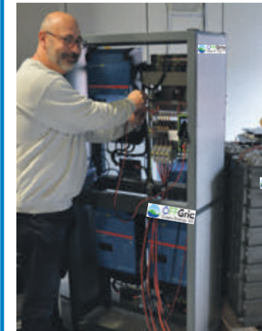
Tobias Lieb bei der Inbetriebnahme eines Speichersystems.
