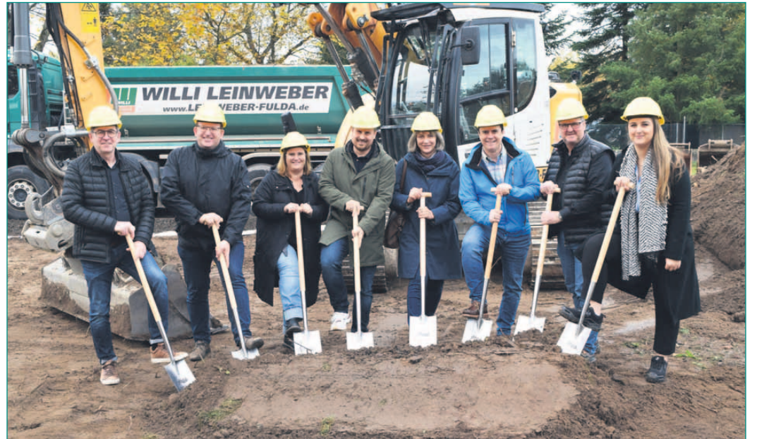
Erster Spatenstich mit Bürgermeister Dr. Bastian und Erstem Stadtrat Michael Gerheim mit Bauamtsleiter Daniel Brauneis und der Leiterin des Amtes für Kinder Iris Knies und den Baubeteiligten. Foto: RM
