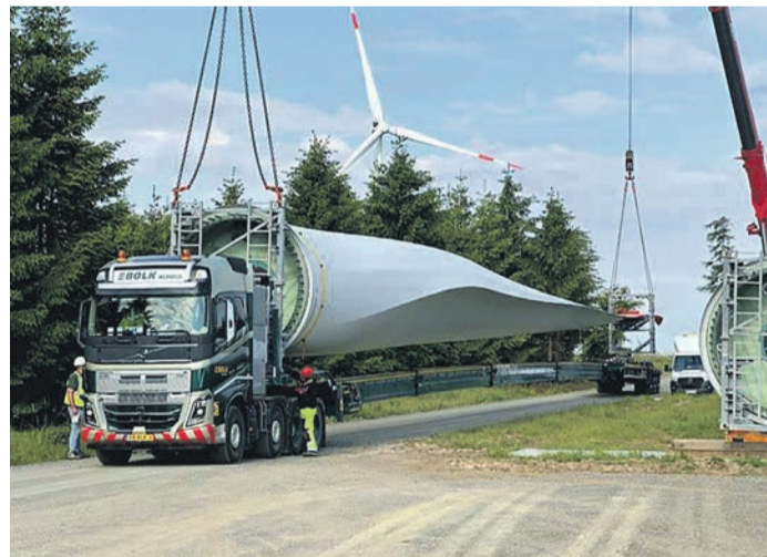
Anlieferung eines Rotorblatts mit Spezial-Lkw am ENTEGA-Windpark Binselberg bei Groß-Umstadt. (Fotos: ENTEGA)
