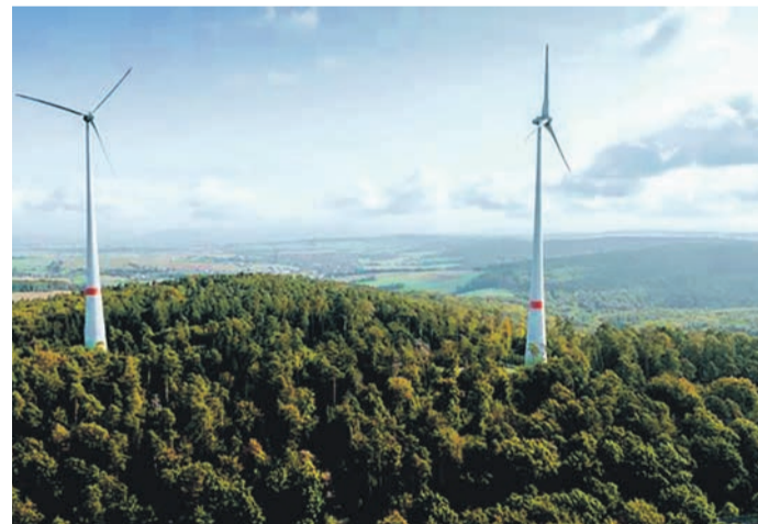
Bei Groß-Umstadt hat die ENTEGA Windenergieanlagen mit einer Leistung von zusammen vier Megawatt errichtet. Die Windräder des Windparks Binselberg erzielen einen Stromertrag von rund 11 Gigawattstunden pro Jahr.
