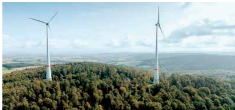
Bei Groß-Umstadt hat die ENTEGA Windenergieanlagen mit einer Leistung von zusammen vier Megawatt errichtet. Die Windräder des Windparks Binselberg erzielen einen Stromertrag von rund 11 Gigawattstunden pro Jahr.
