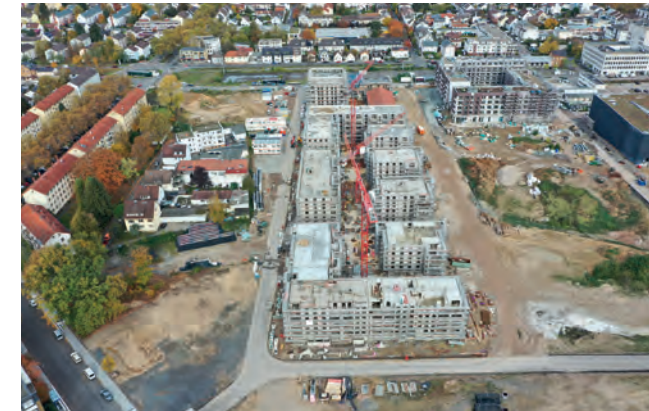
Rohbauarbeiten im westlichen Baufeld der GEWOBAU
