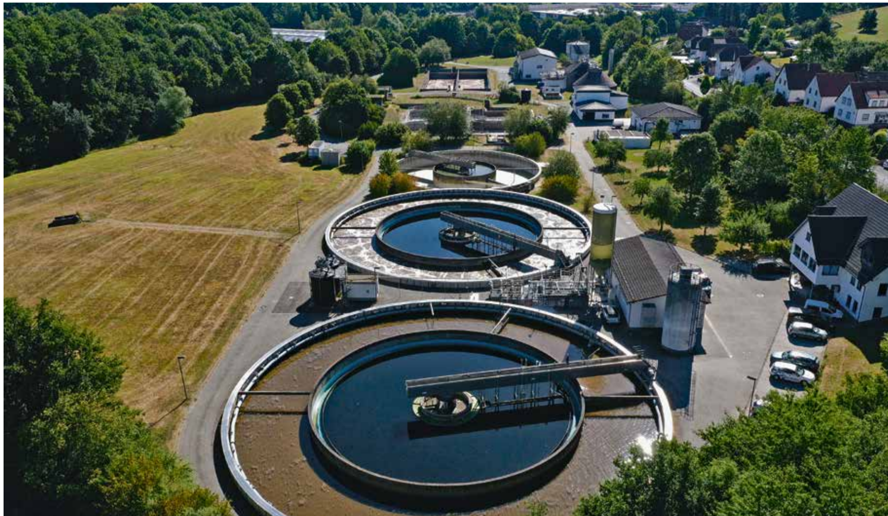
Vorreiter in punkto Recycling: Im Klärwerk in Michelstadt soll ab Mitte 2024 aus Klärschlamm Phosphat gewonnen werden können.
