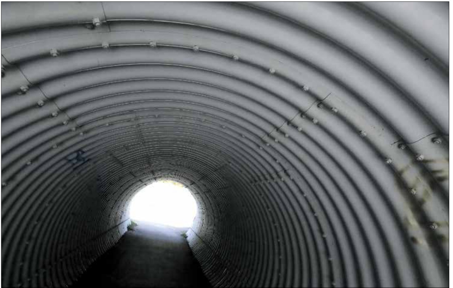
Licht am Ende des Tunnels.
