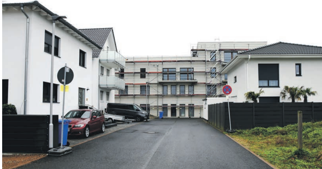
Im Eppertshäuser Baugebiet „Am Abteiwald“ wächst inmitten von Wohnhäusern das Caritas Seniorenzentrum heran. Das Foto zeigt das kleinere und niedrigere Gebäude, in dem zwölf der 38 barrierefreien Wohnungen untergebracht werden. (Foto: jedö)
