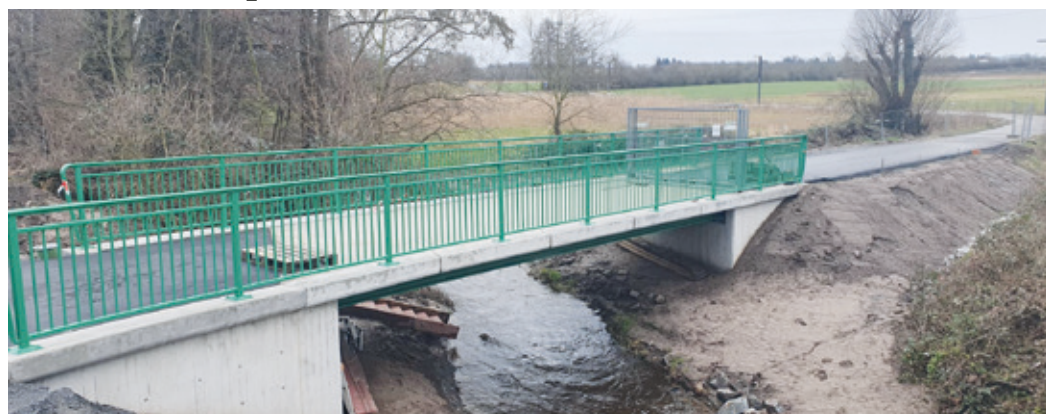
Der auf lange Zeit vorerst letzte Teilabschnitt des Radschnellwegs wird demnächst fertiggestellt. Mühlbachbrücke neben der Aumühle. (Foto: Thomas Stetz)
