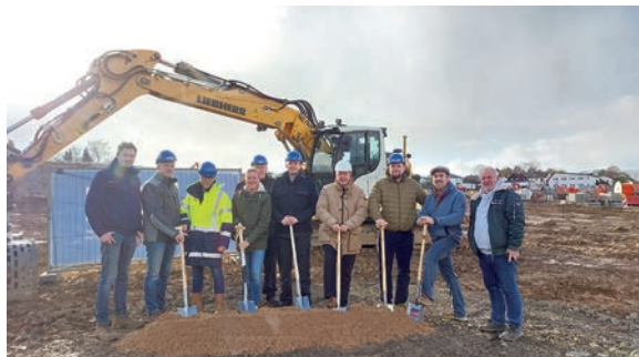
Beim ersten Spatenstich zum neuen Petterweiler Feuerwehrhaus (v.l.): Bauunternehmer Eric Schrempf, Harald Kirch vom Kommunalen Immobilienmanagement, Architekt Marc Jacobs, Stadtrat Stephan Theiß, stellv. Leiter Stadtpolizei Uwe Axtmann, stellv. Stadtbrandinspektor Martin Strehl, Bürgermeister Guido Rahn, Rene Rapior, Ortsvorsteher Dennis Vesper und Joachim „Schöni“ Schönberger
