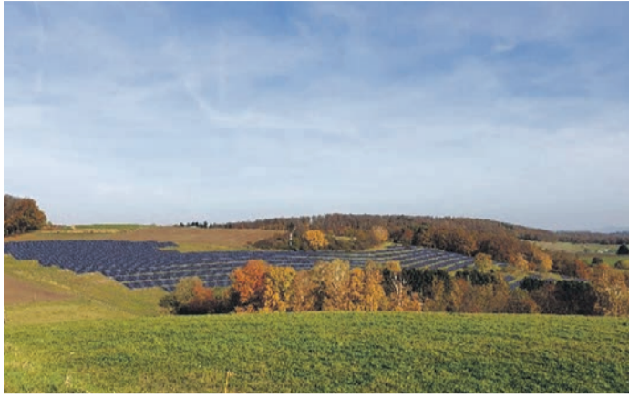
Der Bürgersolarpark Klein Bieberau (Gemeinde Modautal) ist ein gemeinsames Projekt der ENTEGA mit der Energiegenossenschaft Odenwald und soll Ende 2024 in Betrieb gehen. (Foto: ENTEGA)
