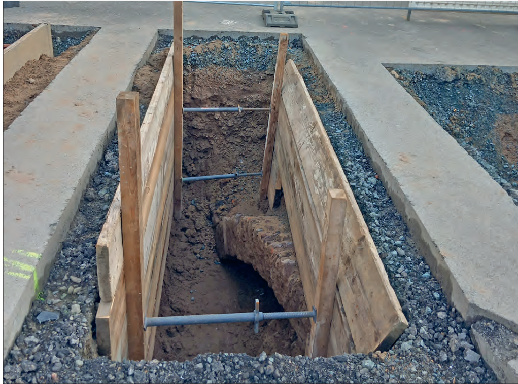
Bogenförmiges Mauerwerk in einer Baugrube zwischen Reiterdenkmal und Weißem Turm.
