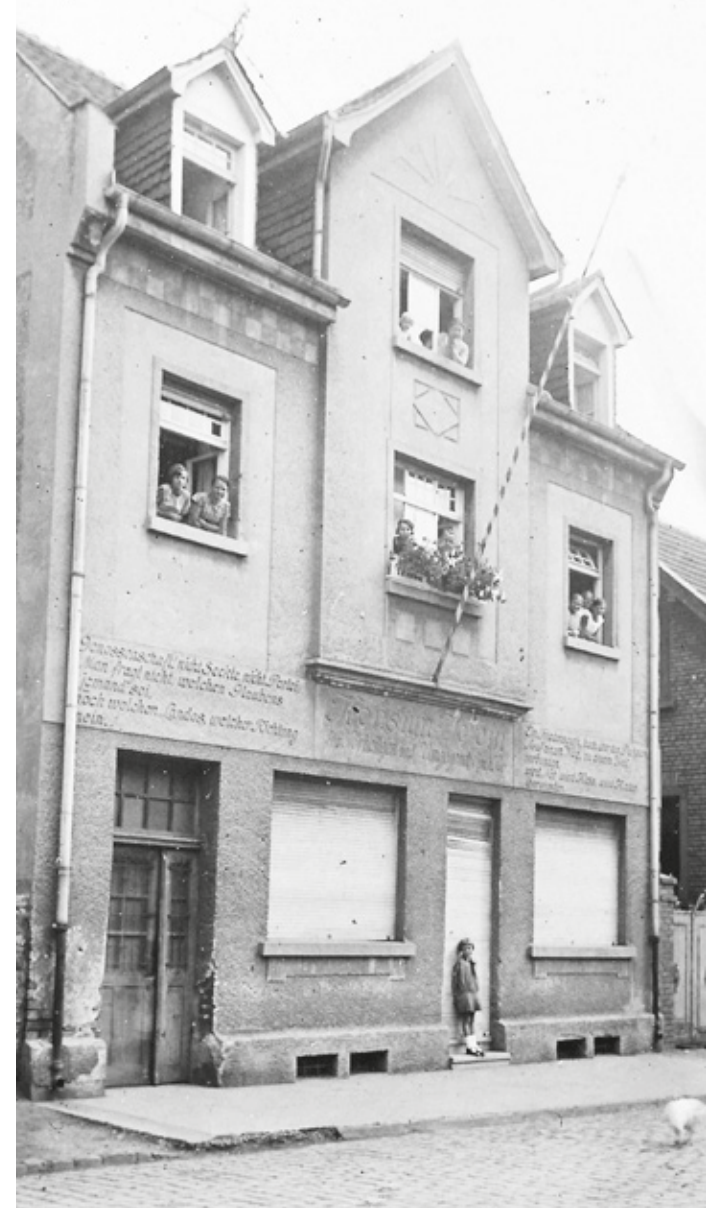
Im November 1909 bezog die Arheilger Konsumgenossenschaft das neu errichtete Geschäftshaus in der Unterer Mühlenstraße. Die Genossenschaft hatte für die Versorgung der Arbeiterfamilien eine große Bedeutung. Im ersten OG schauen Familienmitglieder des Lagerhalters Karl Müller aus dem Fenster. Heute ist die Odenwald Apotheke in dem Gebäude untergebracht. (Foto: W. Kumpff/AGV)
