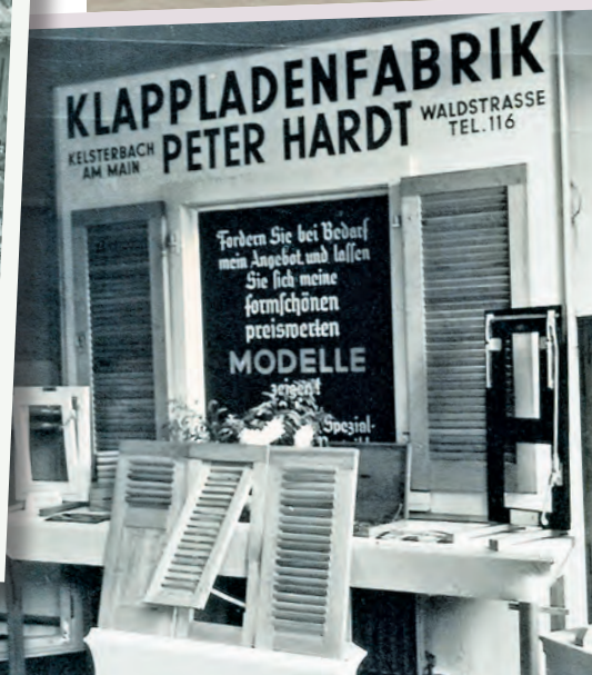
Spezialfabrik Peter Hardt, 1952 Klappläden, Waldstraße 133
