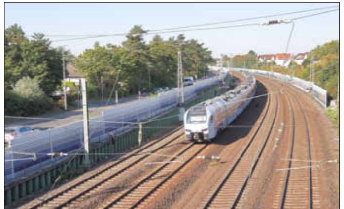
.....Wahlweise unter Strom oder mit Diesel.
