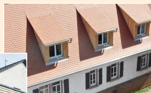
» Steildach mit Biberschwanzeindeckung
