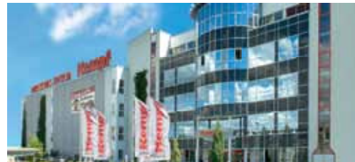
1999 Baubeginn Möbel Kempf in Aschaffenburg. 150 neue Mitarbeiter, 30.000 m 2 Verkaufsfläche. Neueröffnung nach Rekordbauteit am 27. Juli 2000
