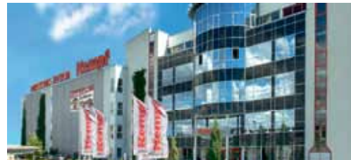
1999 Baubeginn Möbel Kempf in Aschaffenburg. 150 neue Mitarbeiter, 30.000 m² Verkaufsfläche. Neueröffnung nach Rekordbauteit am 27. Juli 2000
