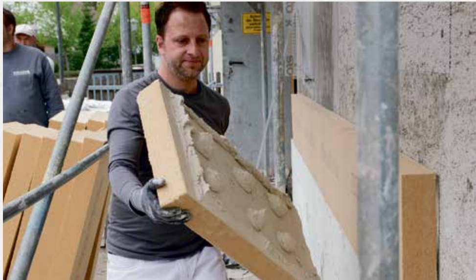
Holzfaser-Dämmung bindet CO 2 in der Fassade, durchschnittlich etwa so viel, wie ein Kleinwagen auf 50.000 Kilometer freisetzt. Foto: steico.com/akz-o
