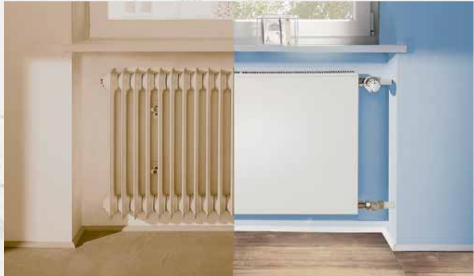
Alt vs. neu: Ein neuer Heizkörper verleiht dem Raum nicht nur einen frischen Look, sondern sorgt auch für Energieeinsparungen. Für einen einfachen Austausch sollten die Nabenabstände der Renovierungslösung genau mit denen der alten DIN-Radiatoren übereinstimmen. Foto: Kermi GmbH/akz-o
