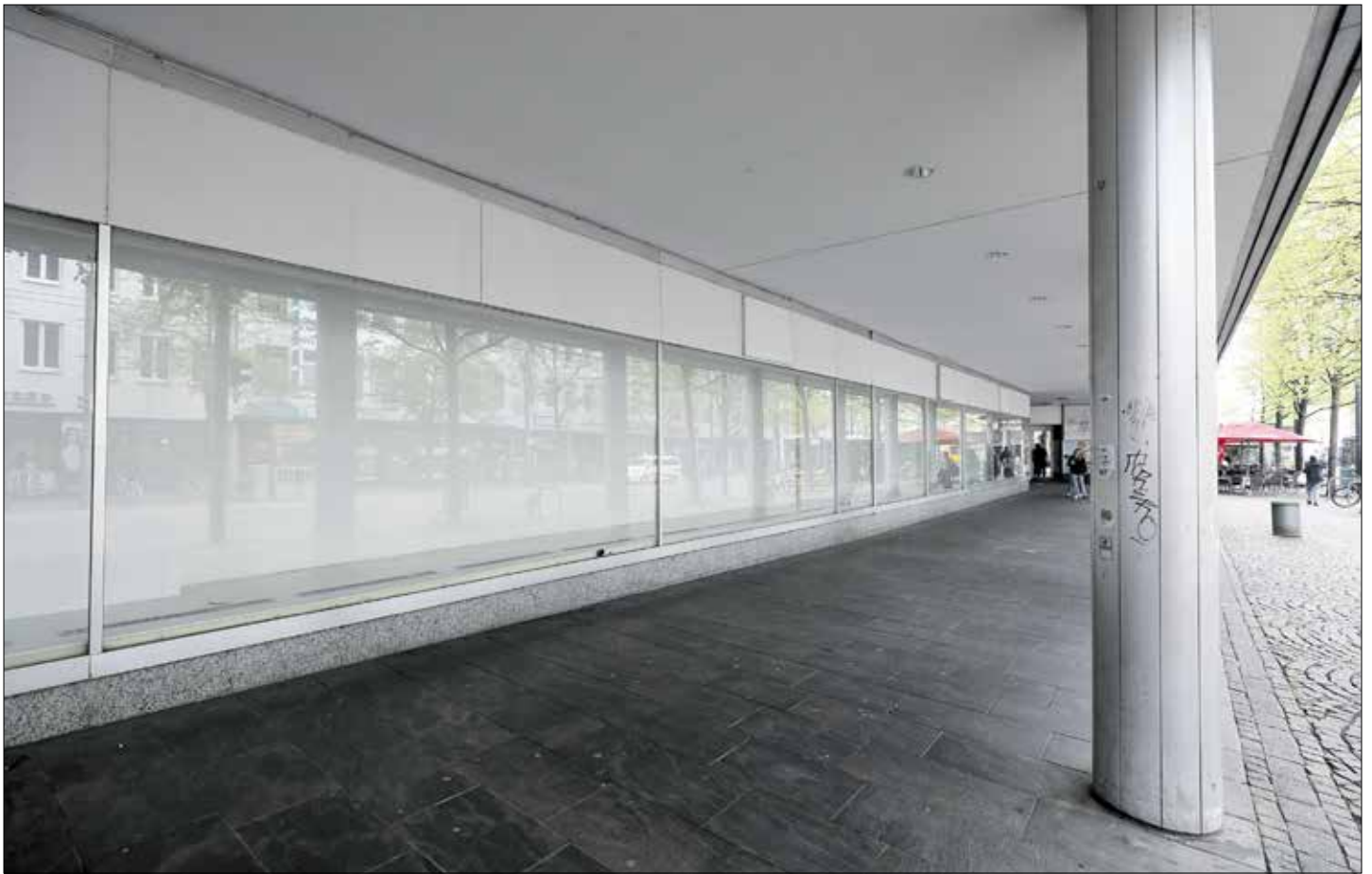
Was wird hier wohl entstehen? Mal abwarten. Und bis dahin den Leerstand sinnvoll füllen.
