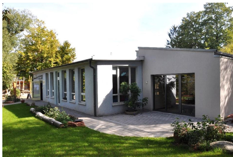
Erweiterung Kita Friedrich-Fröbel-Haus
