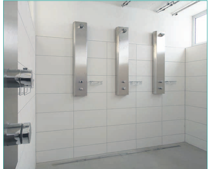
Die Herren-Duschen sind komplett erneuert worden.
