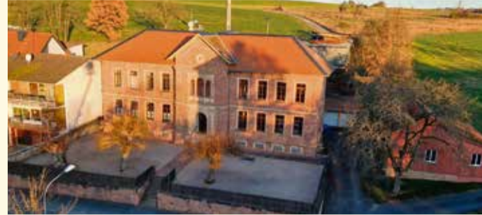
Das ehemalige Schulhaus und jetzige Standesamt in Langenbrombach. Foto: Gemeinde Brombachtal
