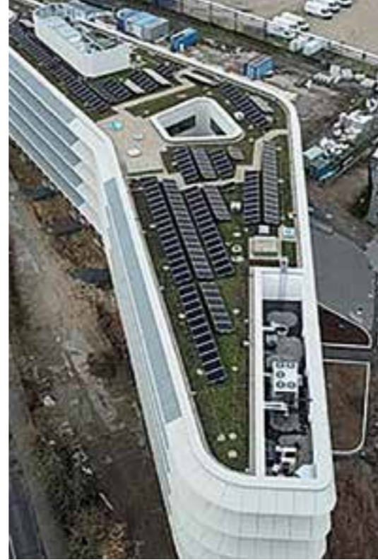
Das neue ENTEGA-Verwaltungsgebäude in der Kasinostraße in Darmstadt kann seinen Energiebedarf zur Hälfte mit seinen Photovoltaik-Anlagen auf dem Dach und an der Fassade decken.
